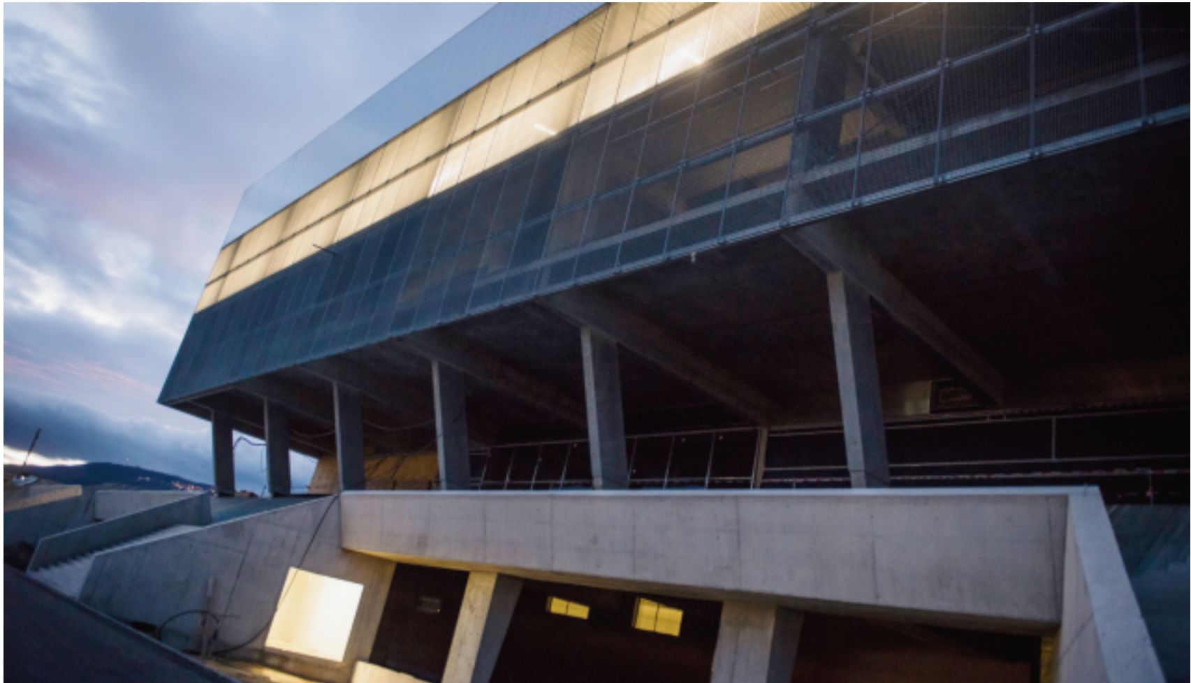
Die Hülle der Tissot Arena sieht fertig aus. Doch im Innern der Sportstadien wurde der Baustellen-Endspurt lanciert.
